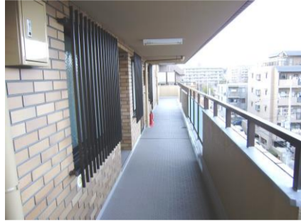
コメント: 防音効果の高いシートを使用、幅も広めに設計されています
