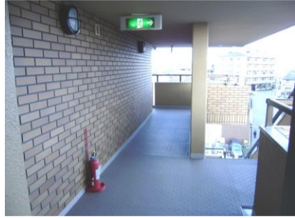
コメント: 防音効果の高いシートを使用、幅も広めに設計されています
