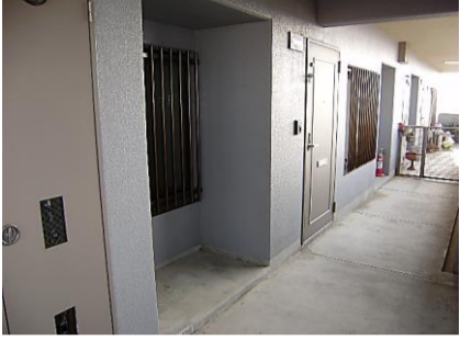
コメント: 空調室外機置場あり
