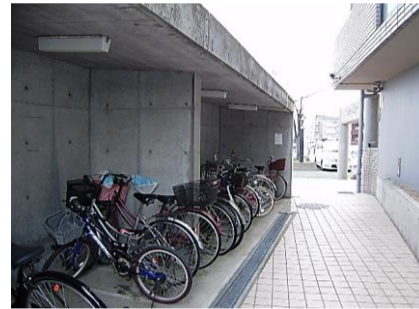
コメント: 屋根付駐輪場
