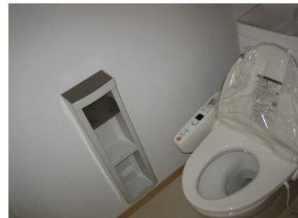
洗浄便座設置
