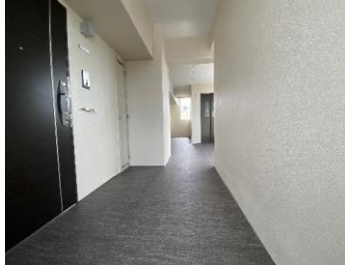
コメント: 共用廊下 長尺シート貼り
