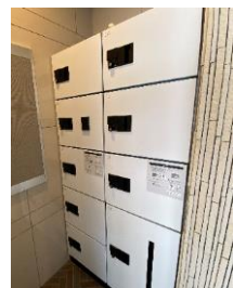
宅配BOX設置
