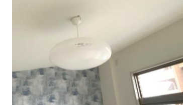
10Fのみ勾配天井の為ペンダントライト
