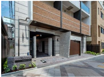
コメント: 外観タイル貼り
