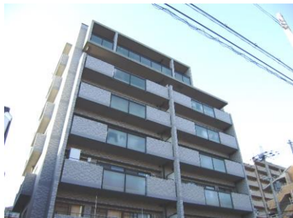
コメント: 外観タイル貼り
