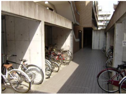
コメント: 屋根付き・屋内駐輪場あり
