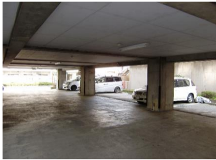
コメント: 屋内5台 屋外24台
