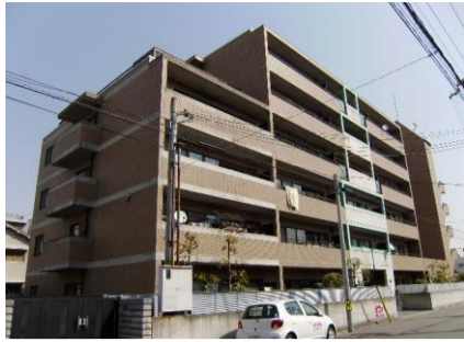
コメント: 外観タイル貼り
